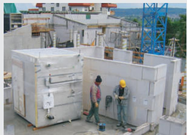
**KONŠTRUKČNÉ VYHOTOVENIE** - bunky sa vyrábajú zo zhutneného betónu akostnej triedy C 35 : 2 400 kg/m<sup>3</sup>, resp. LC 25 : 1 800 kg / m<sup>3</sup> s monolitickou konštrukciou, ktorá zahŕňa steny, podlahu a strop v oceľových debneniach. Vonkajšie steny viditeľné po montáži, umožňujú svojou povrchovou úpravou nanášať nátery a tapety.
